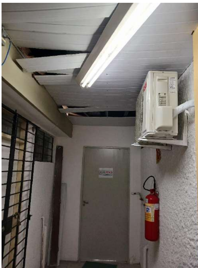
Figura 3: forro de PVC deteriorado.
