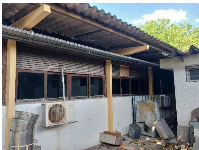
Figura 5: trecho de fachada em que se evidencia as telhas em fibrocimento.
