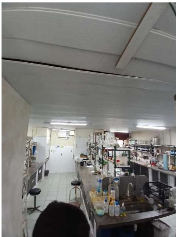
Figura 6: forro em PVC deteriorado.
