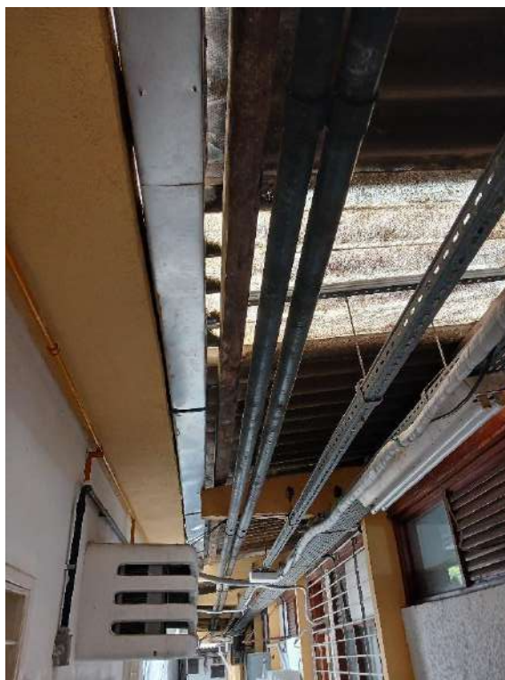
Figura 7: telhas desgastadas e sem uniformidade de material.
